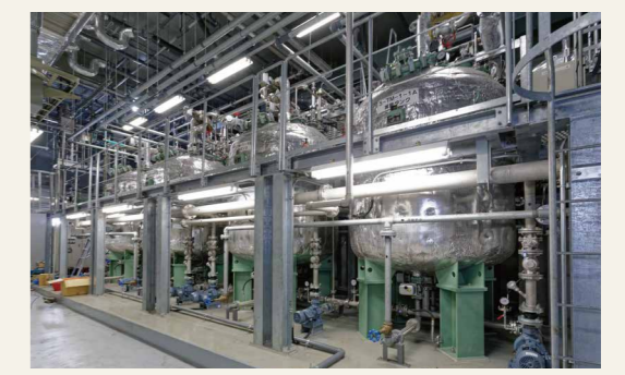
排水処理装置群
